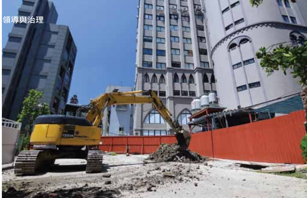
宣教後棟副堂動工
