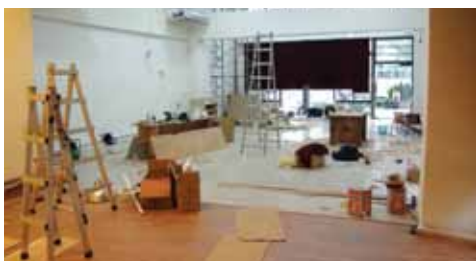
2011年5月19日主會堂施工照片
